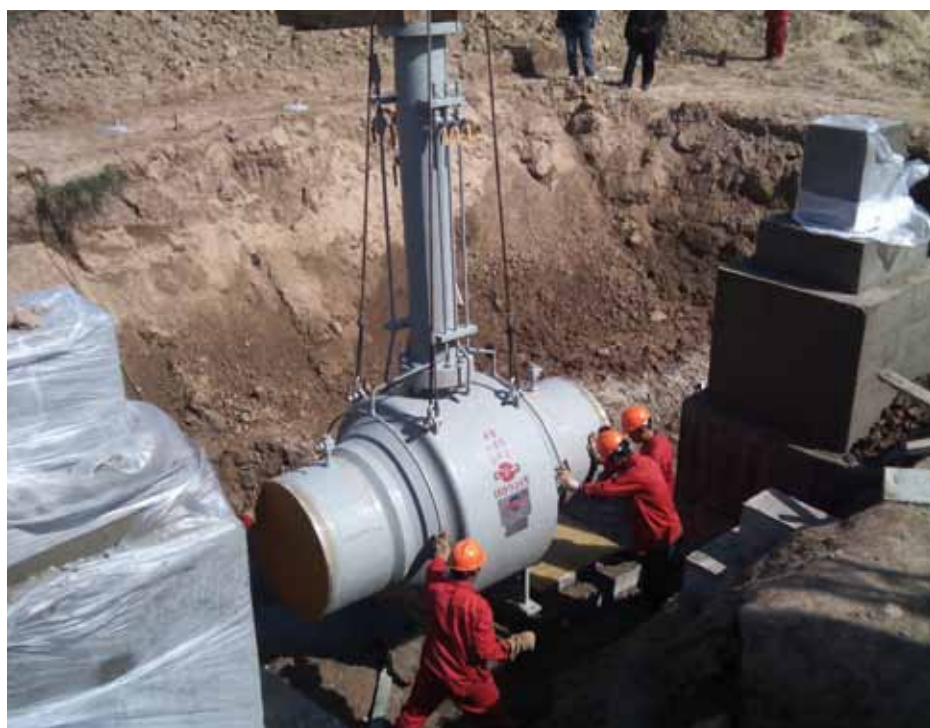
五洲球阀应用于西气东输主管线
