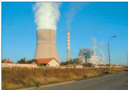
Rotork 在科索沃电力行业重建项目中扮演了主要角色。
