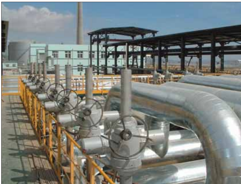
Rotork IQ90 执行器安装在中国一个大型油罐区。
